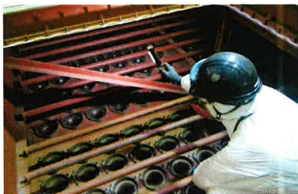
バグフィルター点検状況
