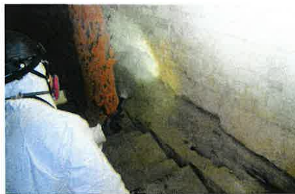
炉内点検状況
